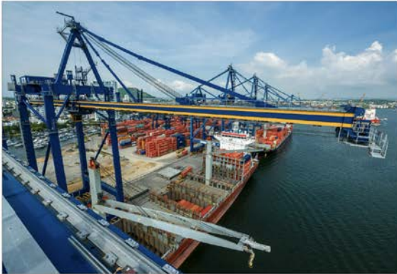
Containerbrücken laufen auf Schienen und haben einen langen wasserseitigen Ausleger zum Beladen von Schiffen.
